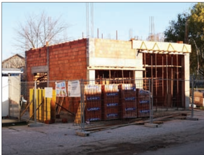
DVD Struga uskoro će se useliti u novo vatrogasno spremište
