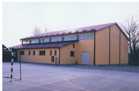
Novoizgrađena sportska dvorana
