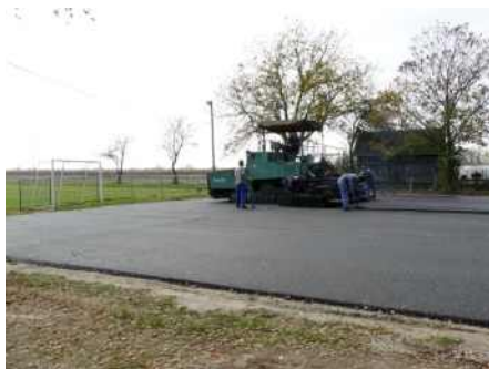
Asfaltiranje igrališta u Strugi
