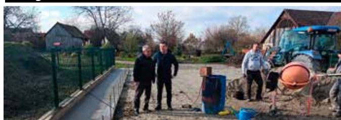
Radovi na dječjem igralištu vrtića Suncokret
