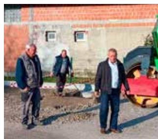
Asfaltiranje parkirališta kod osnovne škole Sveti Đurđ
